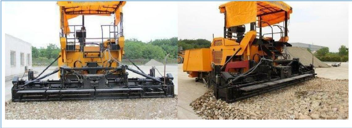
摊铺前下承层路基表面应适量洒水，保持湿润。采用中大摊铺机进行摊铺。在摊铺过程中，速度为 $1.5\text{m}/\text{min}\sim 2.2\text{m}/\text{min}$ 为宜，垫层在开始摊铺 $3\sim 6$ 米长时，现场技术人员立即检测摊铺面的标高及横坡，合格后，再继续摊铺。正常施工时，摊铺机每前进 $10$ 米，检测级配碎石摊铺顶面标高，检测位置同路基顶面检测位置，记录下数据，并根据之前测量的级配碎石底面标高计算出级配碎石松铺厚度及横坡度。同时设专人检测摊铺平整度，不合格时，立即进行调整并记录。
