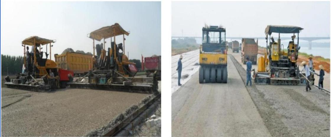
1、两台摊铺机功率必须一致，新旧程度相近，摊铺混合料时，不宜中断，如因故中断时间超过2小时，应设置横向接缝。
