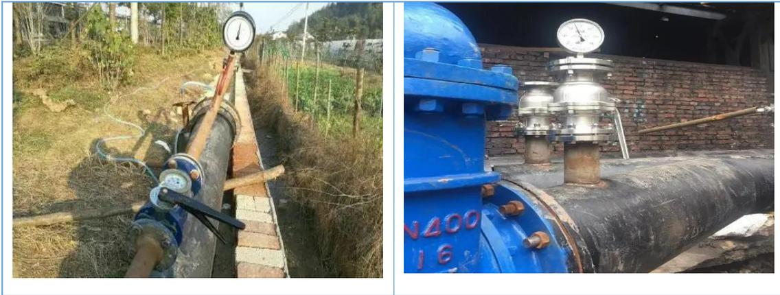
a、压力表：弹簧压力表的精度不能低于1.5级，即压力表最大允许误差不得超过最高刻度的1.5%。最大量程应为试验压力的1.5倍。为方便读数，表壳的公称直径不应小于150mm。且在使用前应校正。
