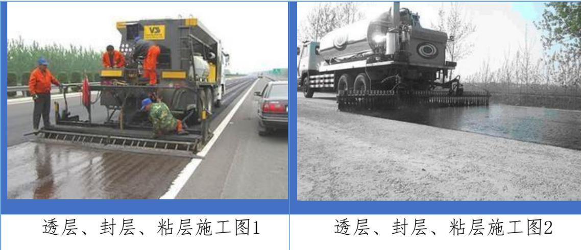
2.3.1 将装好料的摊铺机开至施工起点，对准走向控制线，并调整摊铺箱鬲度与拱度，使摊铺箱周边与原路面贴紧；
