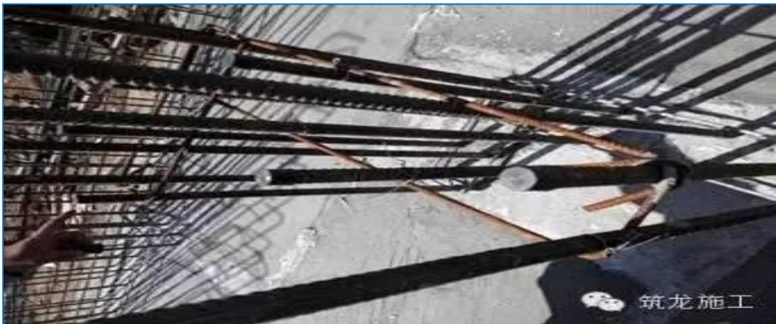
2、后浇带、施工缝等部位预留钢筋长时间搁置，未进行防锈保护处理。
