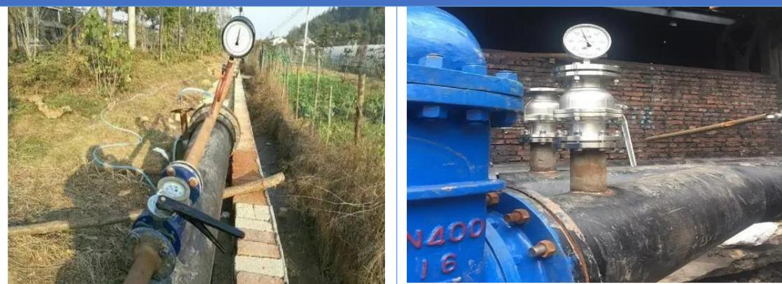
进行水压实验应统一指挥, 明确分工, 对后背、支墩、接口、排气阀等都应规定专人负责检查, 并明确规定发现问题时的联络信号。
