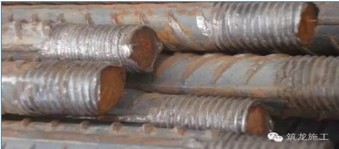
防治措施：钢筋端部直螺纹丝扣加工好以后，套上塑料帽对丝扣进行保护。
