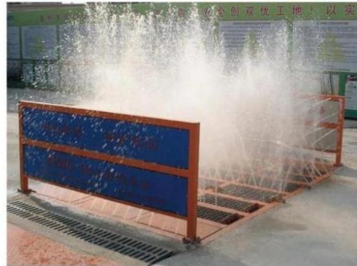
施工现场大门洗车平台示例图一（全自动洗车装置）
