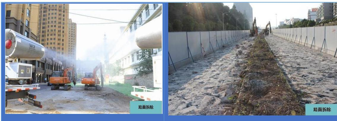
对老路面下能够用于填筑的土石料可取样送检，可用作填筑料，运至填方区填筑。
